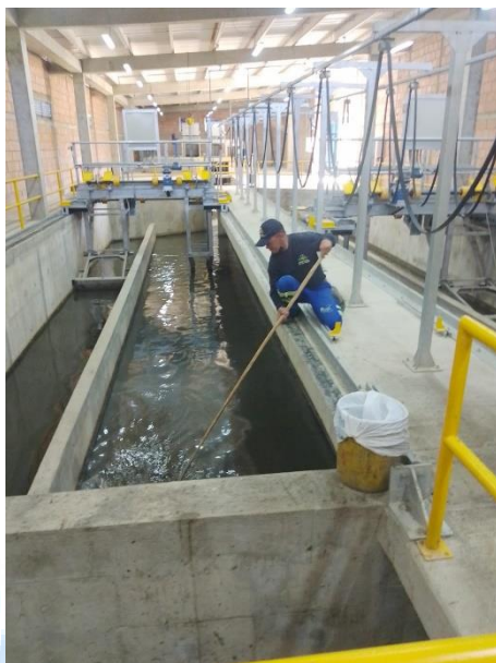
Ilustración 17. Proceso de Limpieza de Partículas sobrenadantes y basura en el desarenador
