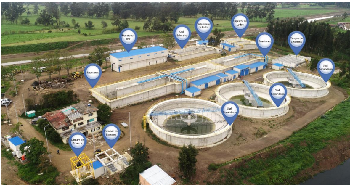
Ilustración 4. Fotografía Aérea PTAR chía 2 Junio, 2020 Previo al Llenado
