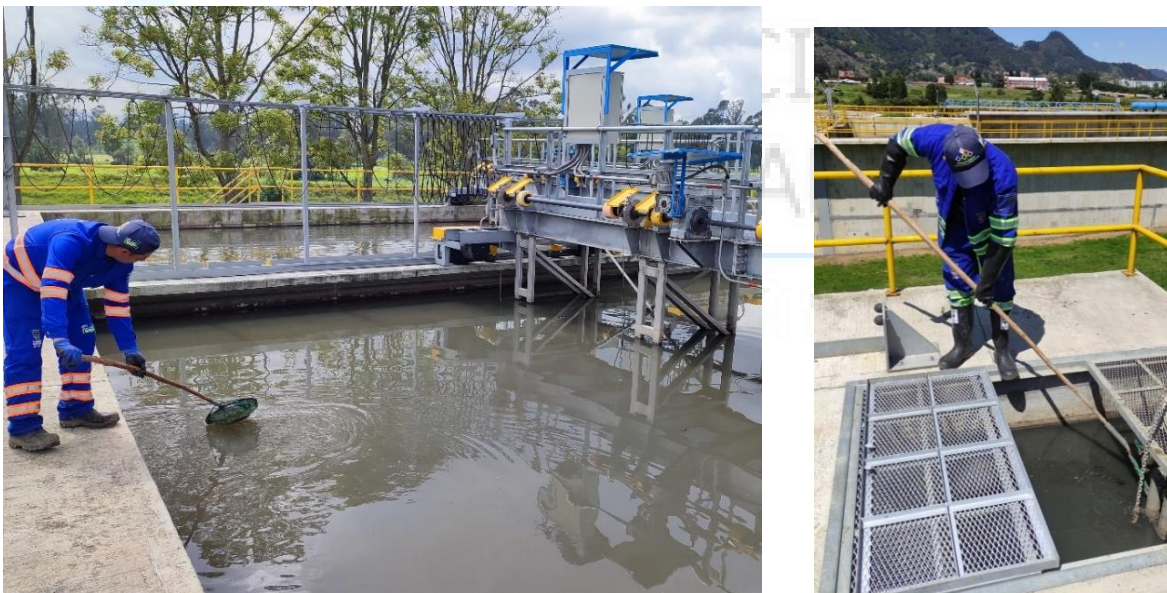
Ilustración 22. Proceso de Limpieza sobrenadantes Sedimentador Primario.
