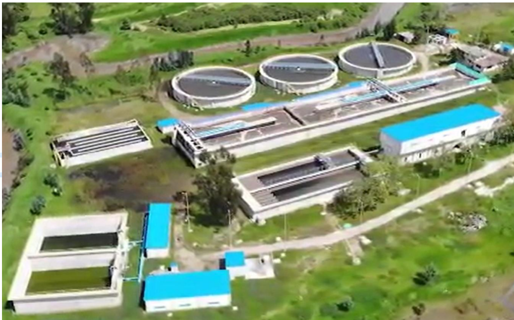
Ilustración 1. Vista General de la PTAR Chía 2
