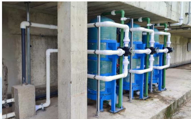
Ilustración 32. Cuerpos Filtrantes de la Planta de Servicio
