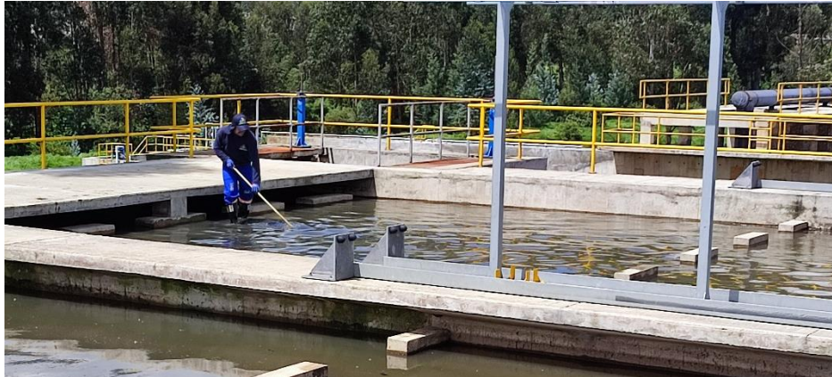
Ilustración 21. Lavado de las canales del Sedimentador Primario
