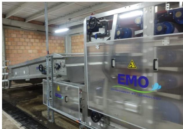
Ilustración 43. Equipo EMO de Floculador, Filtro banda, Mesa Espesadora y Tornillo Transportador
