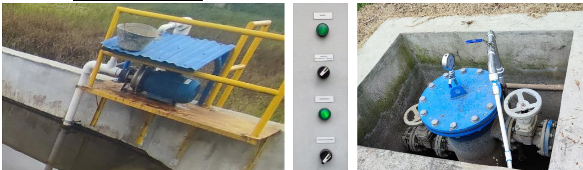
Ilustración 37. (a) Bomba de Servicio (b) Tablero Bomba (c) Cuerpo Filtrante
