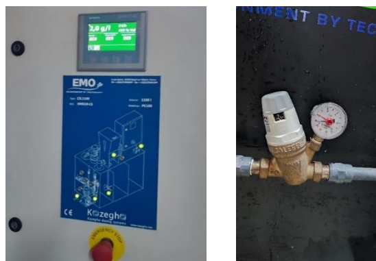
Ilustración 47. Tablero Dosificador de Polímero (Izquierda) Válvula de Presión Caudal para Solución de Polímero (Derecha)
