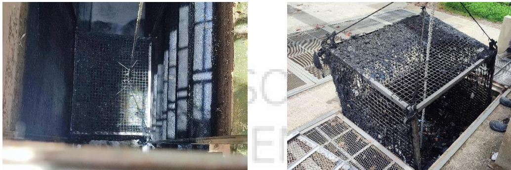
Ilustración 9. Canasta de Gruesos durante 48hrs de operación
